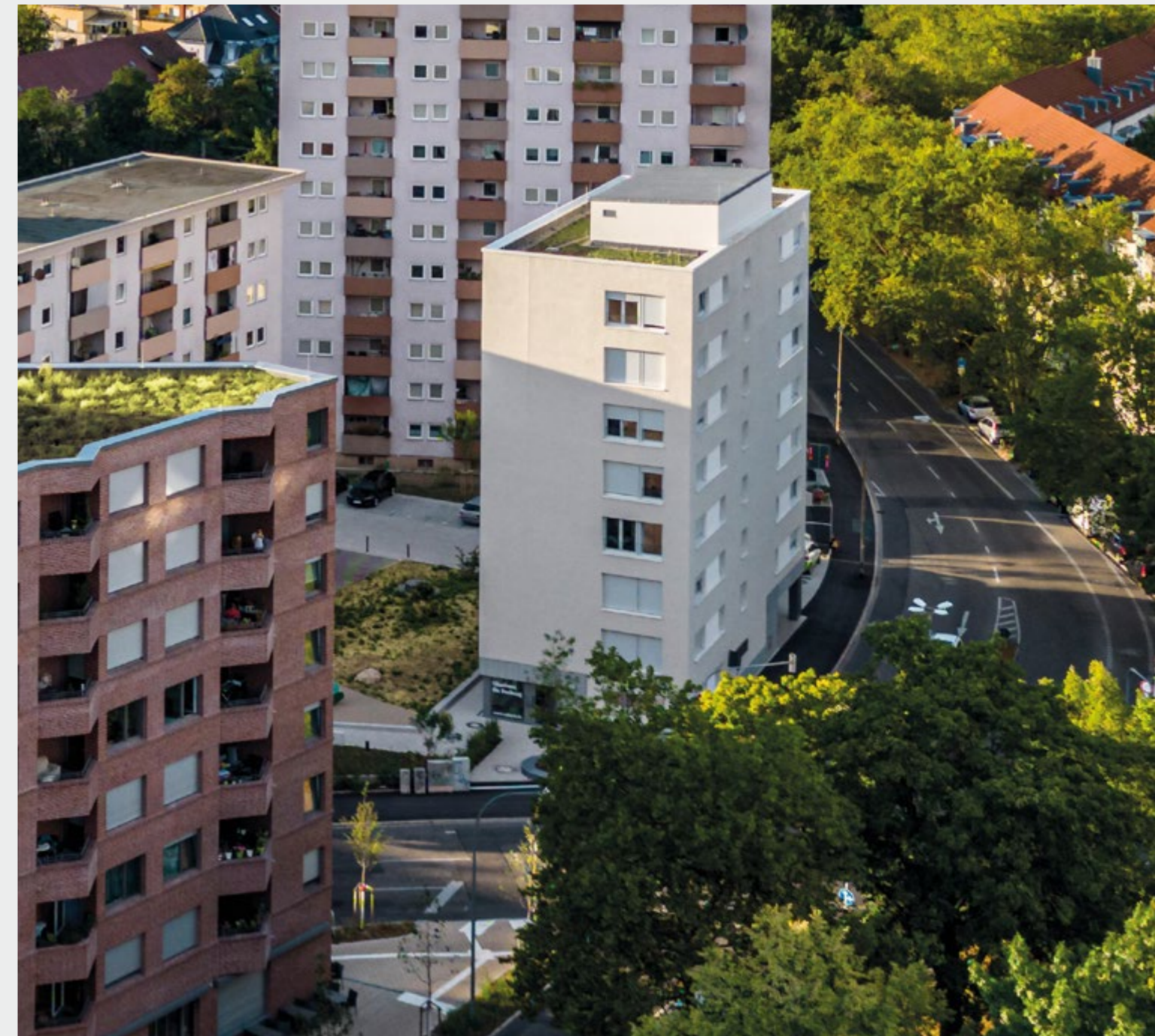
Rennwegdreieck und Stefan-Meier-Straße 167 a
