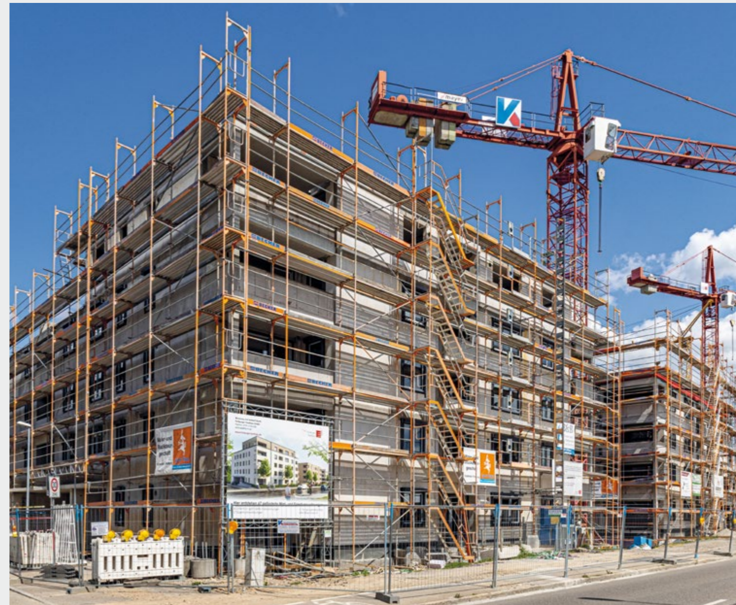
Baustelle der Elsässer Straße 115–119, Ecke Obere Lachen
