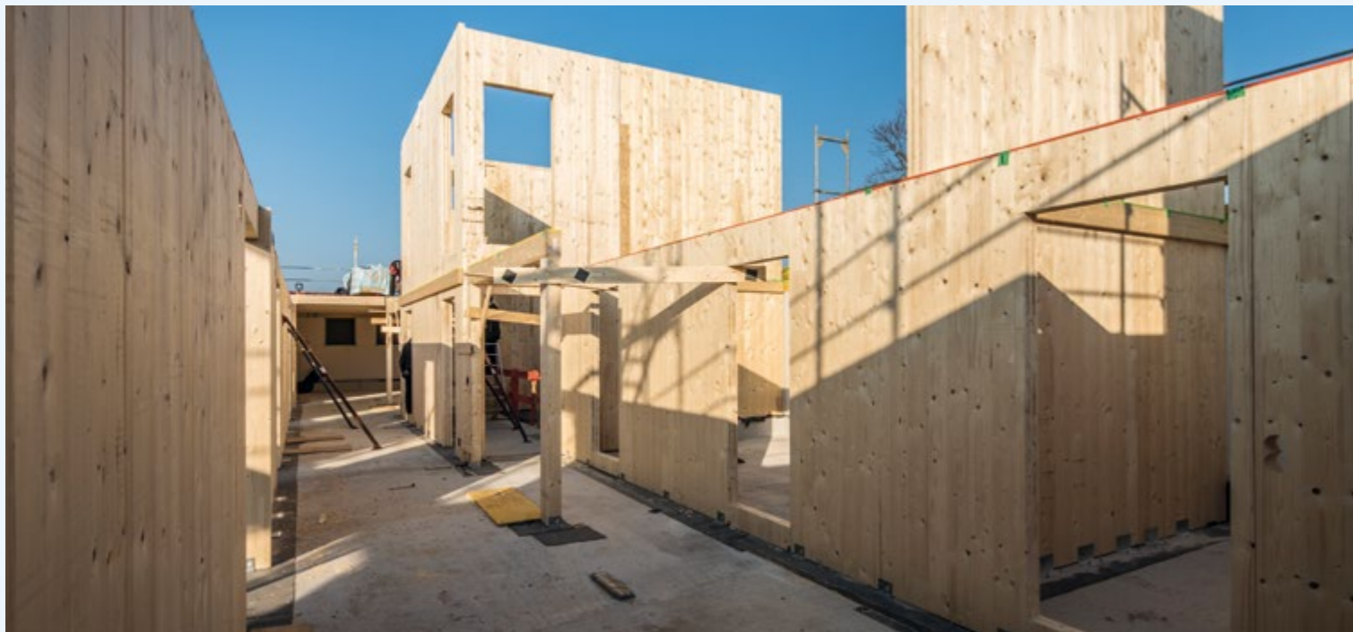
Wohngebäude aus Holz im Bau
