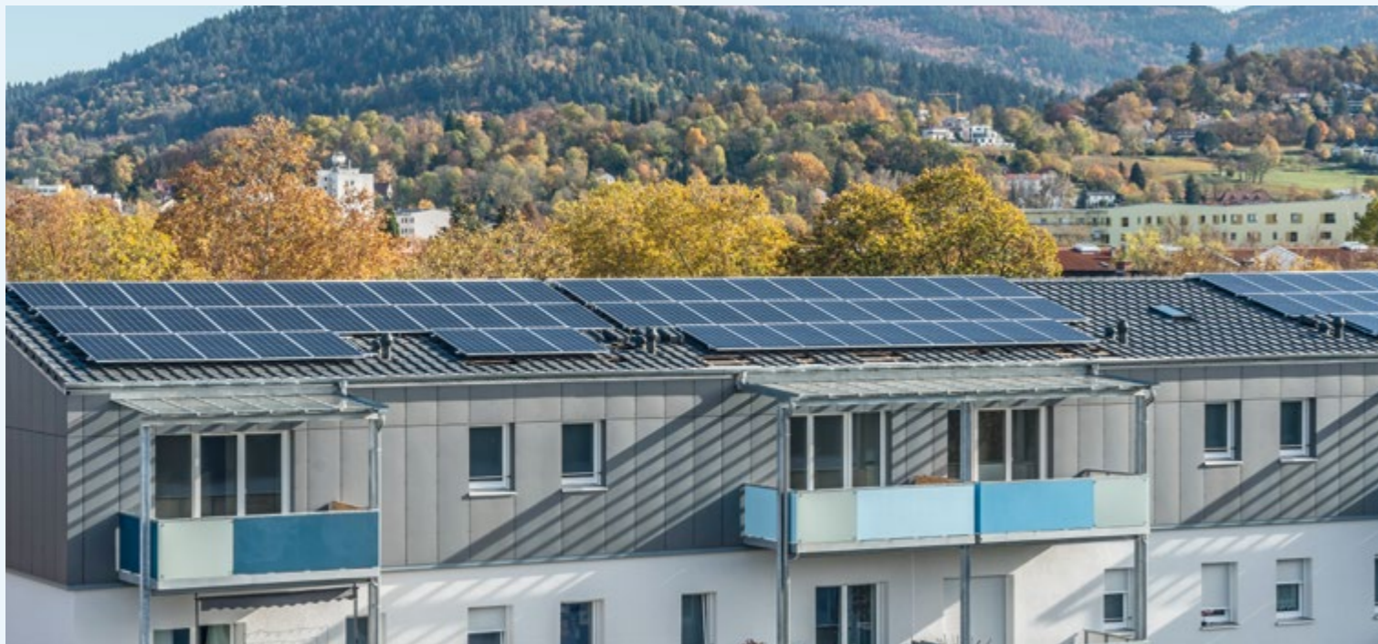
Energetisch saniert und aufgestockt: Belchenstraße 12–36
