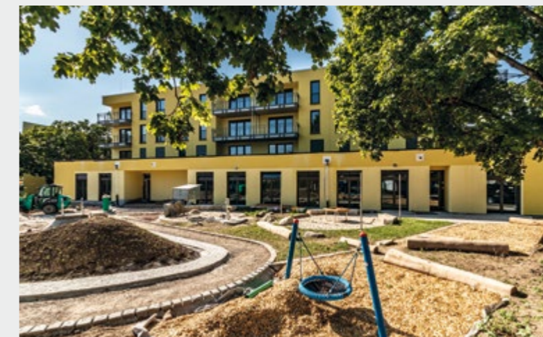
Die Kita und 14 Wohnungen im vierten Bauabschnitt kurz vor der Fertigstellung
