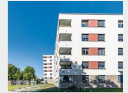
Breisacher Hof, Blick Richtung Breisacher Straße
