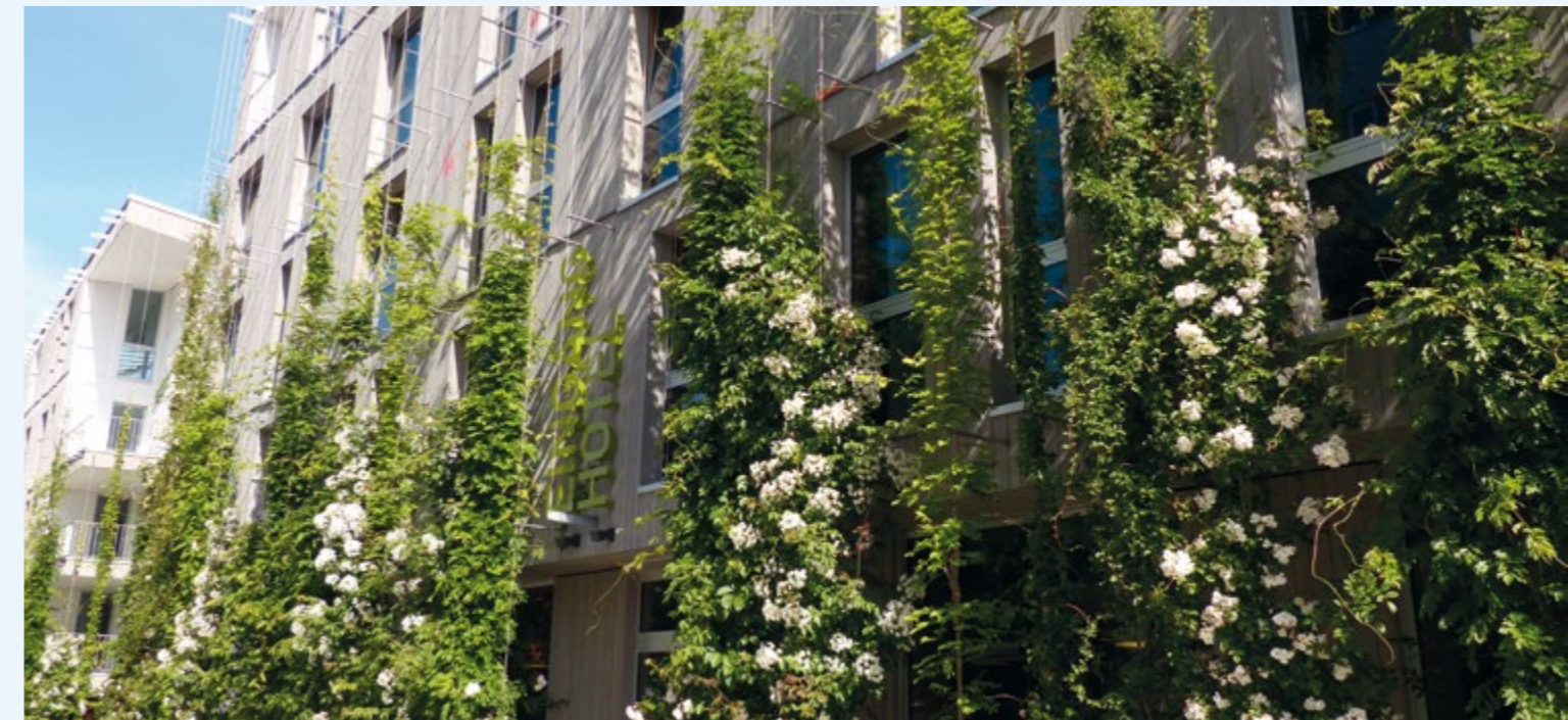
Green City Hotel und Stadthaus M1: Beispiele für die Fassadenbegrünung
