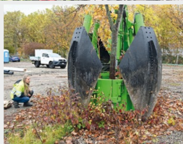
Vorbereitungen für eine Baumversetzung
