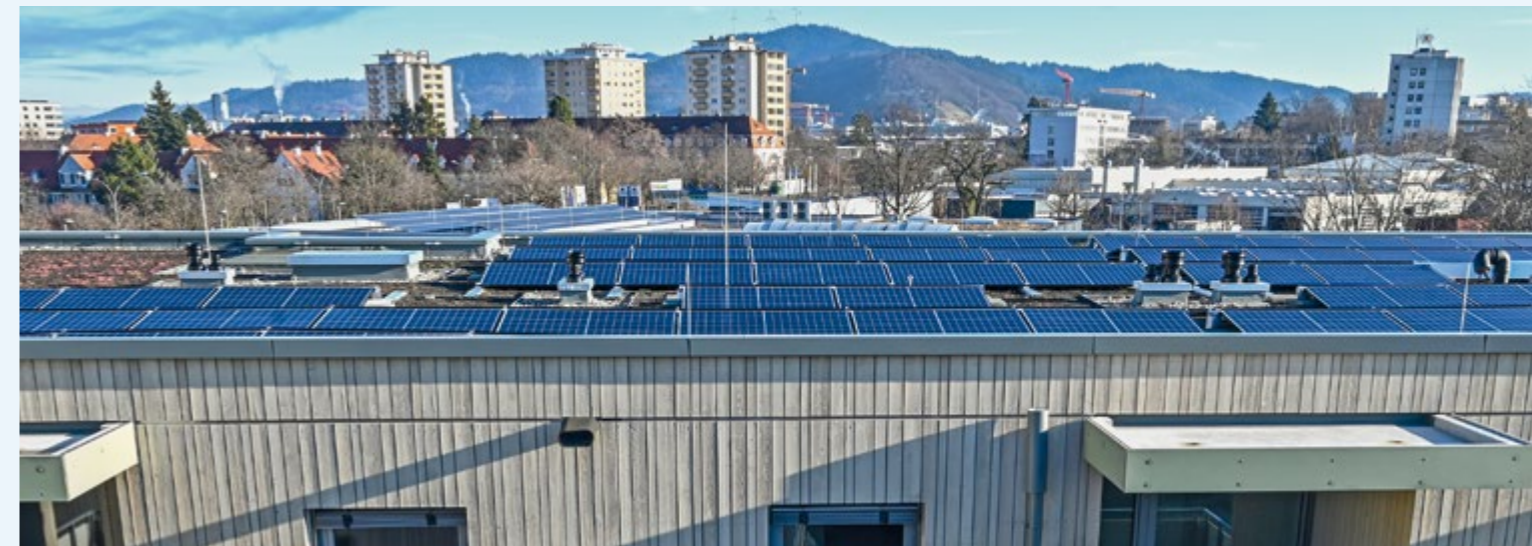
Holzbau und Photovoltaik-Anlage: Elemente nachhaltigen Bauens
