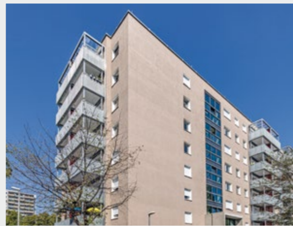
Detail der Eingangsseite
