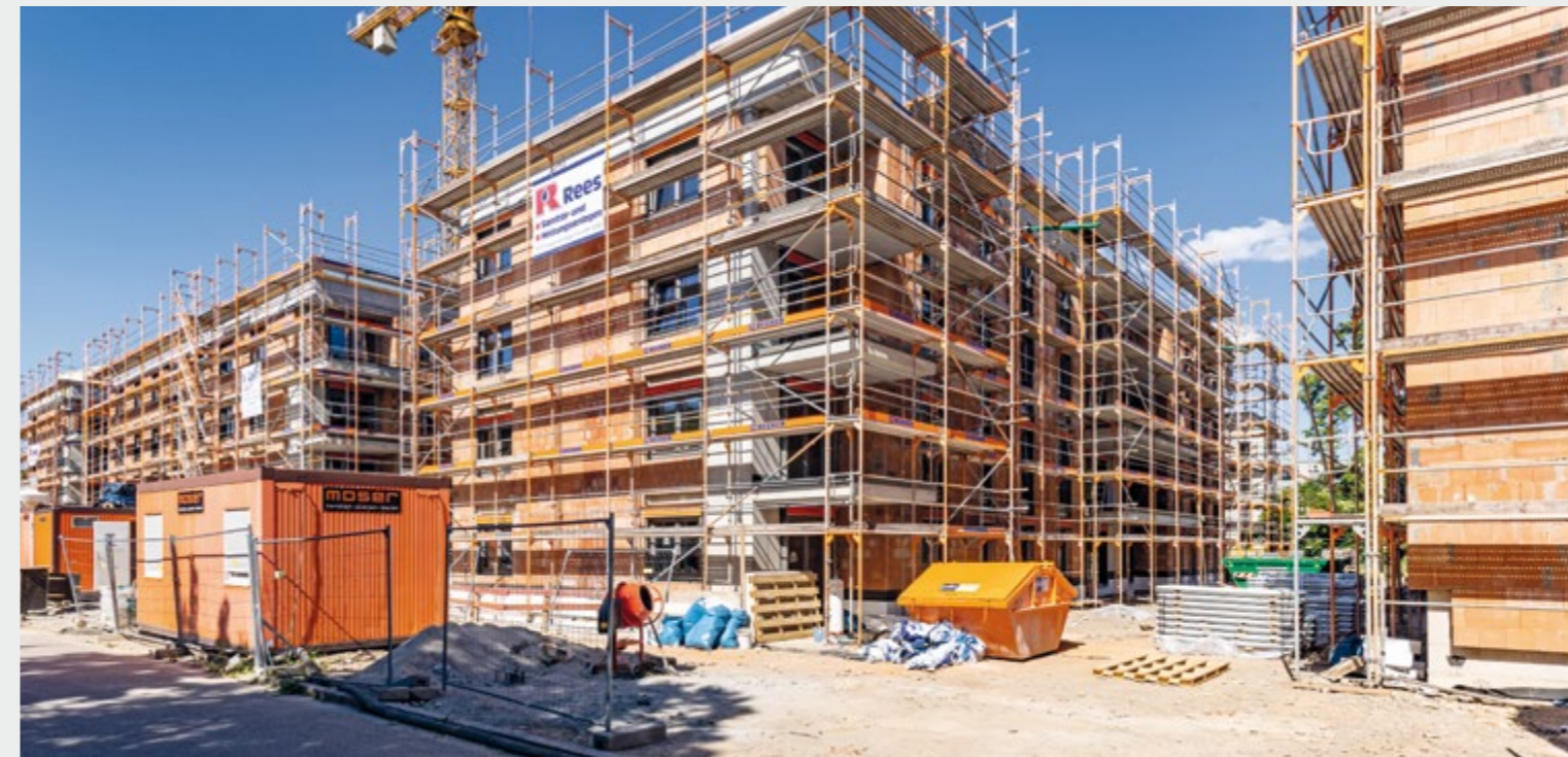
Die Wohngebäude des dritten Bauabschnitts im Bau
