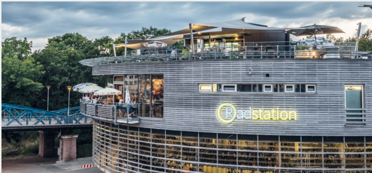
Die Radstation: mehr als ein Fahrradparkhaus
