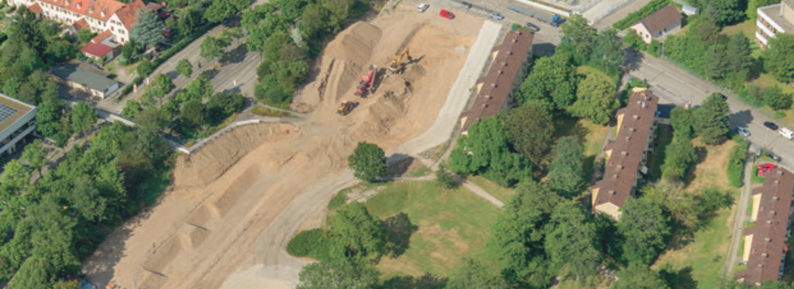
Blick aus der Vogelperspektive auf die Baugrube für den ersten Bauabschnitt
