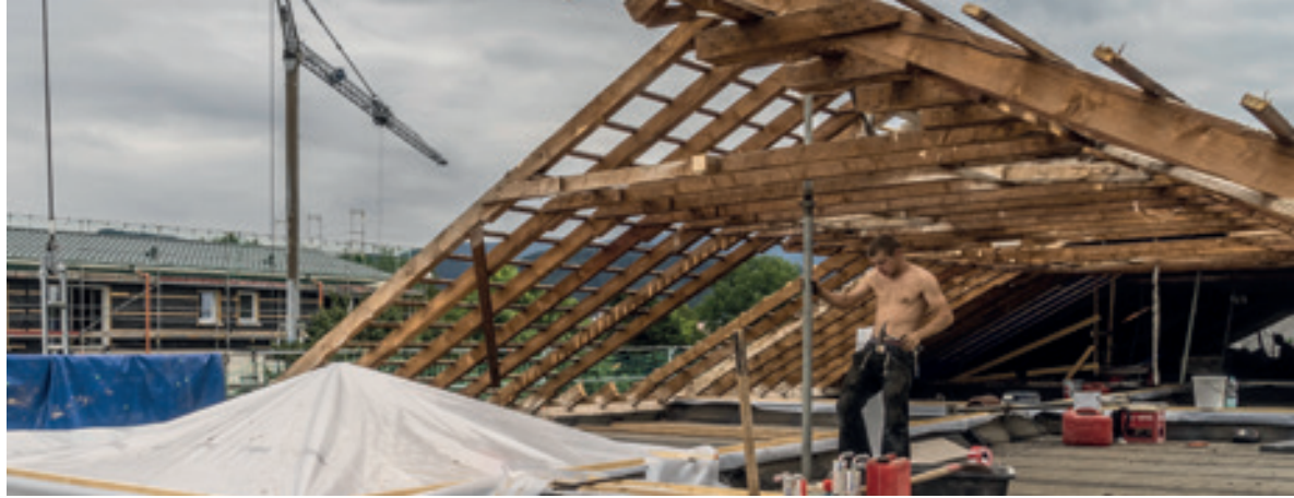
Der alte Dachstuhl wird abgetragen und ein neues Vollgeschoss in Holzständerbauweise auf das Gebäude gesetzt.
