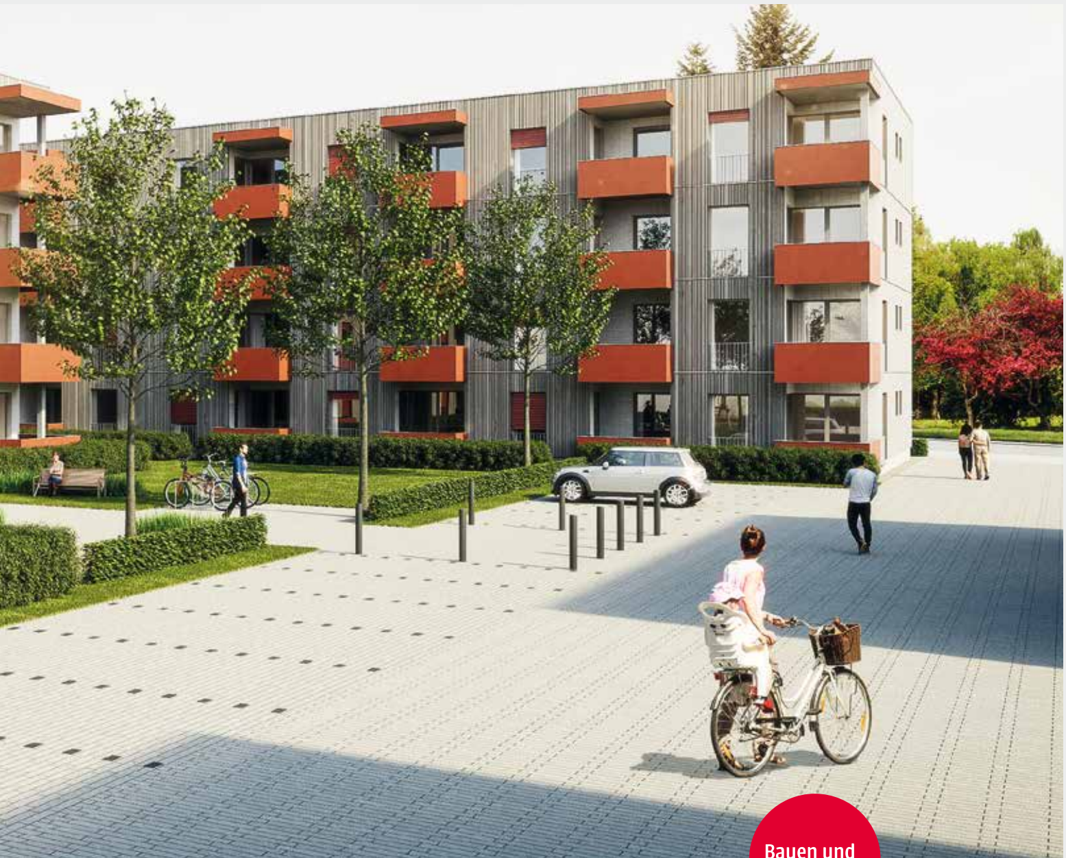
2. Bauabschnitt in Holzbauweise im Quartier Schildacker
