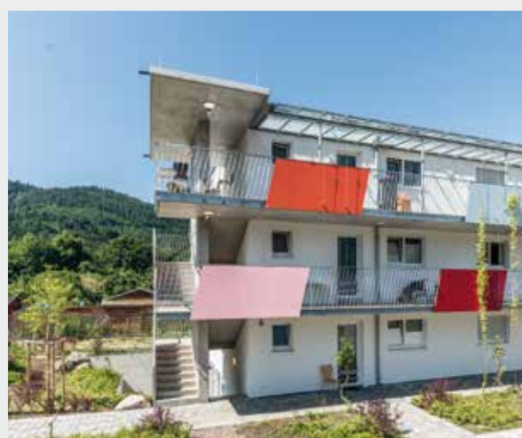
Bergäckerstraße 1. und 2. Bauabschnitt
